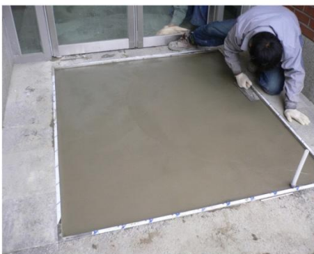
작업 5) 미장 및 양생 작업
