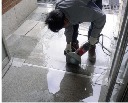
작업 2) 커팅 작업
