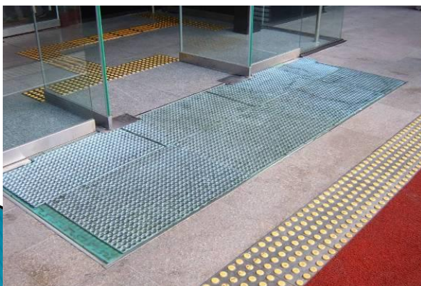
<< 노출형 매트 시공 >>
