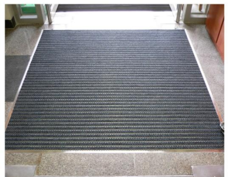
작업 6) 월매트 설치 (작업완료)
