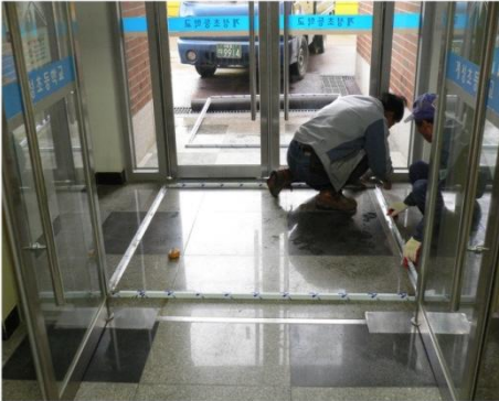
작업 1) 먹줄 작업
